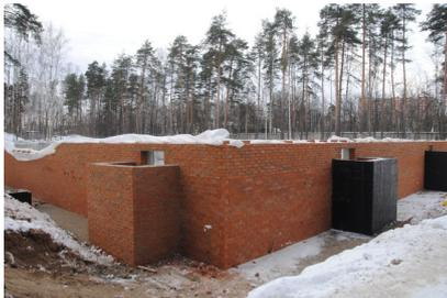
Стройка [жилого комплекса "Вега"](#) продолжается. В декабре наша компания занималась цокольными этажами. Завершено устройство подпорной стенки первого и третьего домов, установлена гидроизоляция на третьем доме. Также начались подготовительные работы по устройству монолитных мембран цокольного этажа второго дома (возведение стен подвала).
